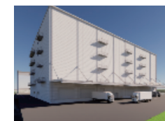
四日市倉庫 (2022 年 9 月竣工予定)
