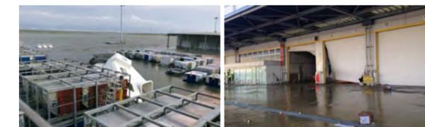
左：浸水した関西国際空港貨物地区。貨物コンテナが水没し、タラップ車の屋根も強風により煽られ破損。右：輸入貨物上屋のシャッターが強風で破損し、豪雨および高潮により浸水。
