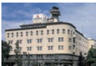
▲1930年 江戸橋倉庫ビル
