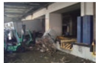
東日本大震災被災状況(仙台配送センター)
