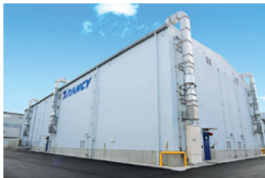
増設した低温（冷蔵）危険品倉庫（河原田倉庫）
