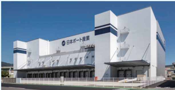
▲神戸住吉冷蔵倉庫の外観
