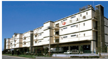
▲姫路港多目的物流倉庫
