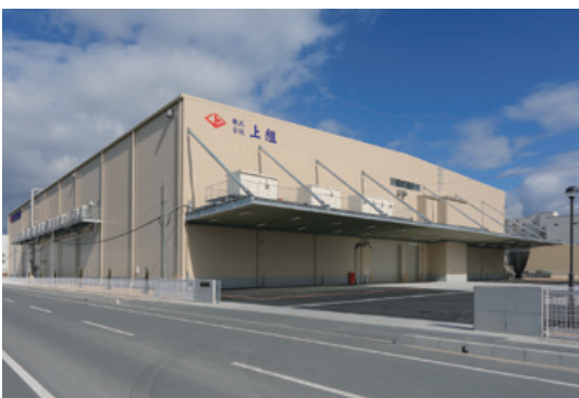
▲玉島ハーバーアイランド物流センターの外観
