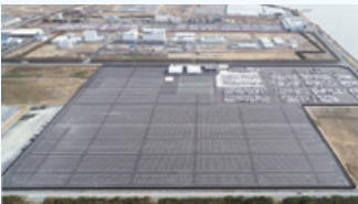
▲ 御津モータープール全景
