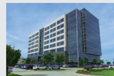
▲ Kamigumi USA Inc.が入居するビル
