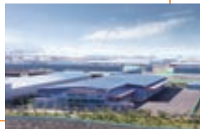
▲釜山倉庫(内外銀山ロジスティクス)
