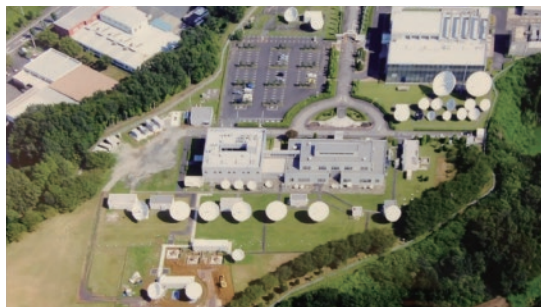
茨城ネットワーク管制センター
