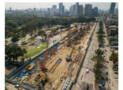
地下鉄建設地周辺の様子(写真提供: JICA)
