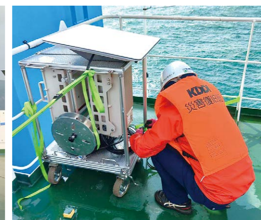
船上でStarlinkのアンテナを固定する様子
