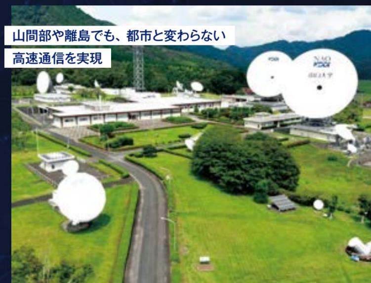
KDDI山口衛星通信所に、Starlinkの通信衛星と地上のインターネット網を接続する地上局を構築
