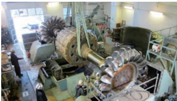
発電電力量の増加に向けて既設水力発電所のリパワリングを実施
