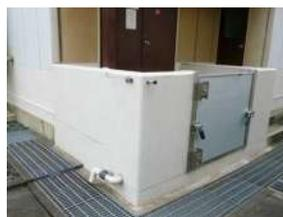
変電所建屋の津波対策(防水壁設置)
