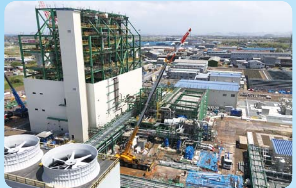
米子バイオマス発電所(建設中)
