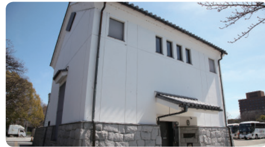
名古屋城の駐車場地下に作られた名城変電所は、周囲の景観にも配慮した入口となっています。
