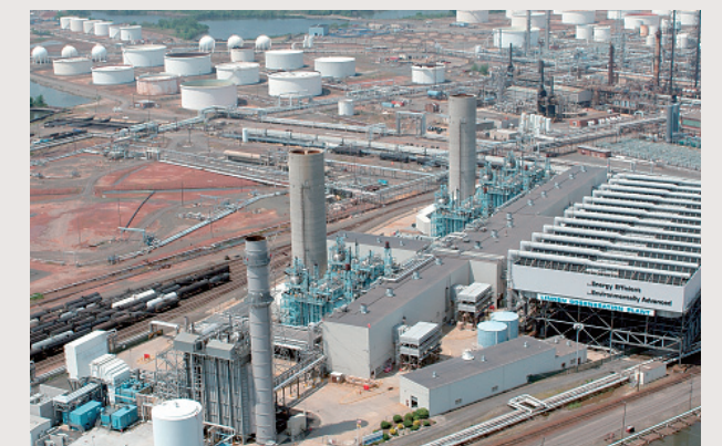
米国ガス火力発電事業 (リンデン)
