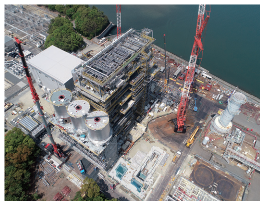
四日市バイオマス発電所の建設の様子
