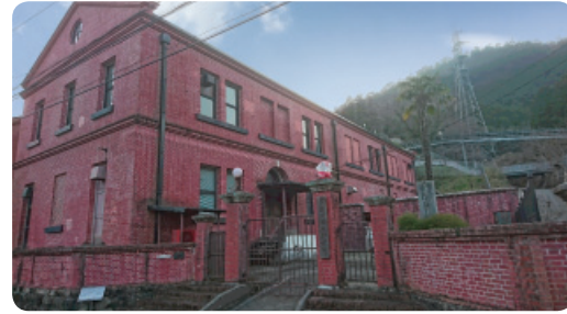
長良川発電所は、登録有形文化財・近代化産業遺産に登録・認定されています。
