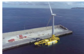
DemoSATH プロジェクト (浮体式)
