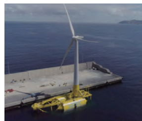
【洋上風力】 スペインビルバオ港沖での浮体式洋上風力実証(DemoSATHプロジェクト)
