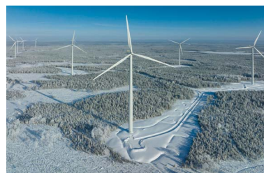
ピーパリンマキ陸上風力発電所
