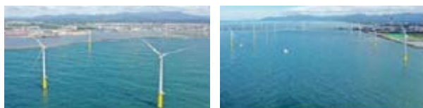
左：秋田港洋上風力発電所、右：能代港洋上風力発電所(提供：秋田洋上風力発電株式会社)
