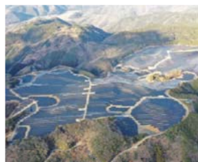
【太陽光】 播州メガソーラー発電所
