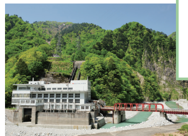
黒部川第二発電所
