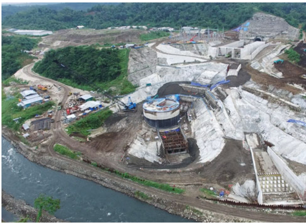
発電所エリアの状況
