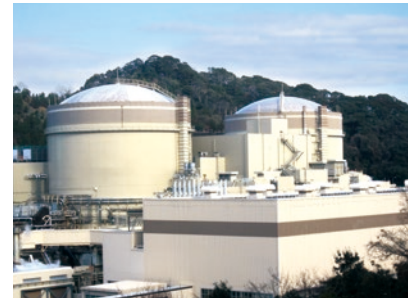
大飯発電所1、2号機
