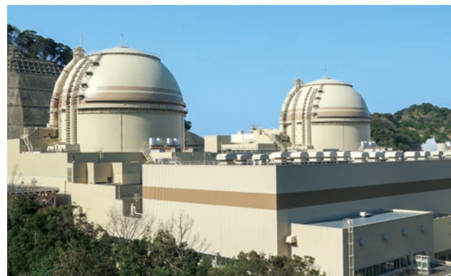
大飯発電所3、4号機
