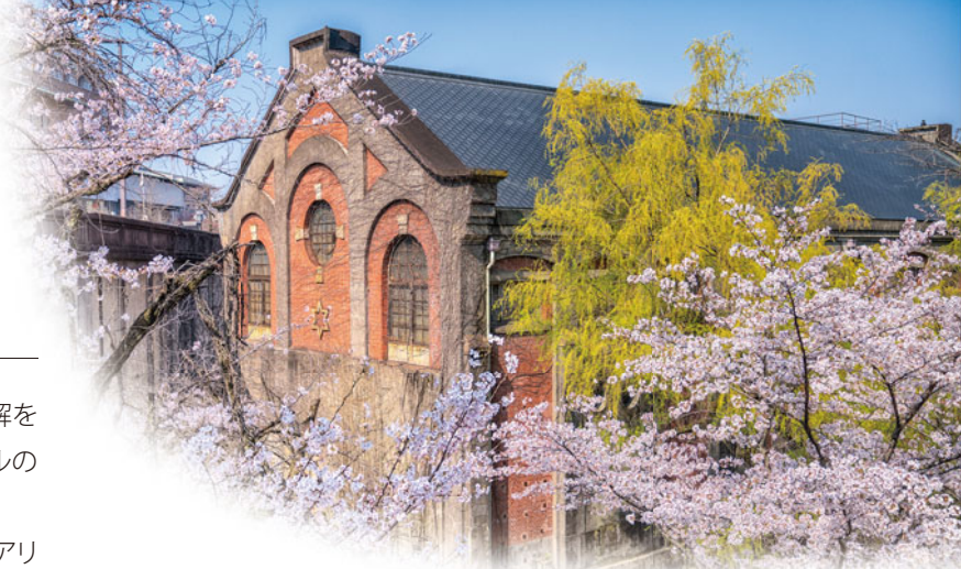
2018年3月から一般公開された蹴上発電所
