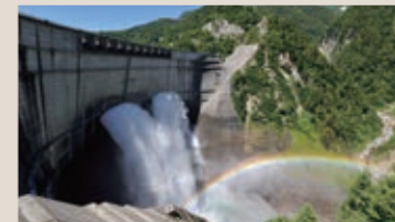
完成した「くらよん」が関西に電気を送る
