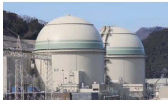
高浜発電所3、4号機
