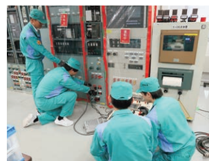
新入社員への系統保護装置点検指導
