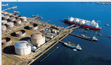
水島LNG基地
