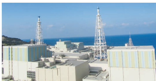
島根原子力発電所
