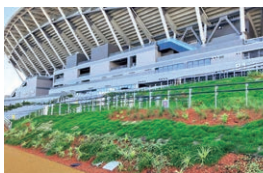
サッカースタジアム(広島市)の北東側スロープの人工土に採用(ライトサンド)
