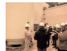
東海第二乾式貯蔵施設
