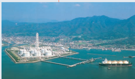
柳井LNG基地
