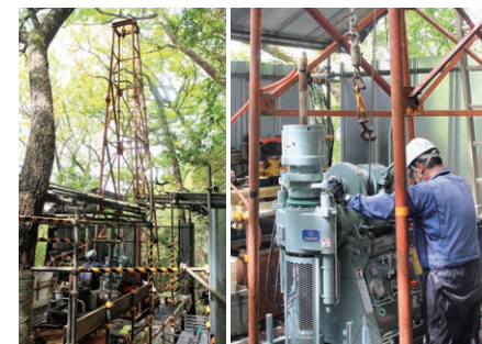
ボーリングによる地質調査の状況
