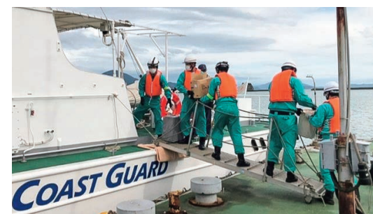
第六管区海上保安本部 柳井海上保安署巡視艇「くががぜ」による復旧資機材・人員の輸送(2022年9月:台風11号の影響による山口県柳井市平郡島における停電の復旧作業)
