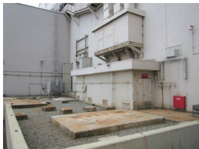
主変圧器、所内変圧器 撤去作業後の状況
