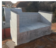
大田静間道路 跨道橋におけるコンクリート混和材(エコパウダー)
