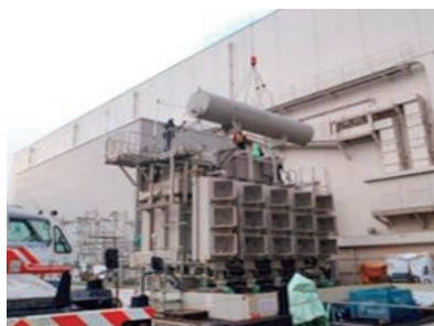
主変圧器、所内変圧器 撤去作業の状況
