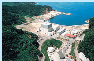
島根原子力発電所1号機(1974年)
