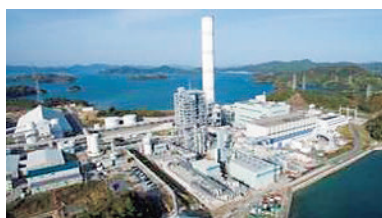
実証試験設備の様子
