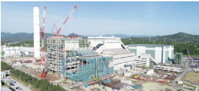
三隅発電所2号機建設工事の様子
