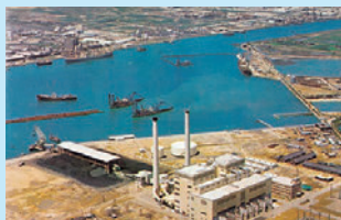
水島発電所(火力)(1961年)
