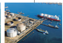
水島LNG基地
