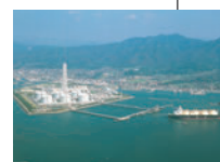
柳井LNG基地
