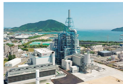
防府バイオマス・石炭混焼発電所
