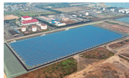
福山太陽光発電所
