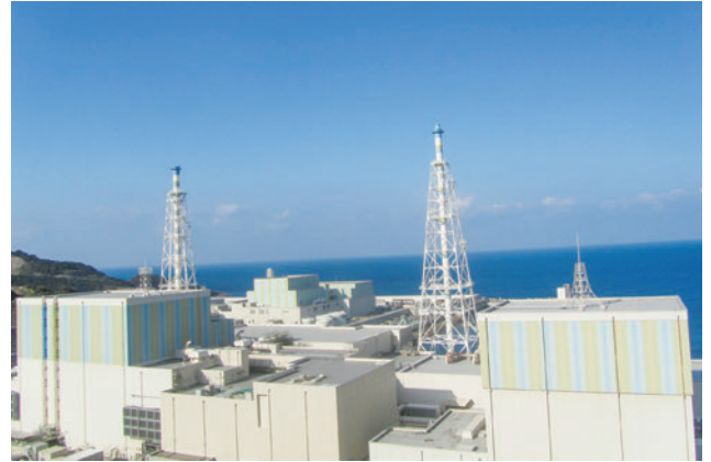
島根原子力発電所
