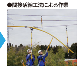
● 間接活線工法による作業
