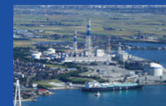
富山新港火力発電所LNG1号機
