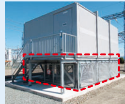
建物の高上げ
