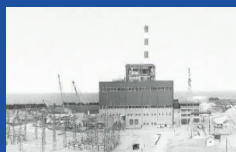
富山火力発電所1号機
