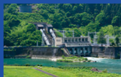
神通川第一発電所(水力)
