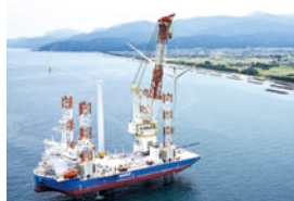
自己昇降式作業台船 (SEP 船) による海上施工の様子
