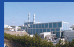
志賀原子力発電所2号機
