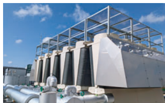
空調設備(ヒートポンプチャラー)
