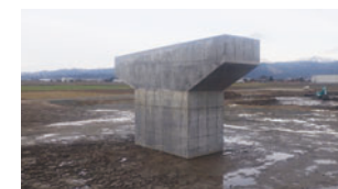
公共工事における施工例(橋脚工事)
