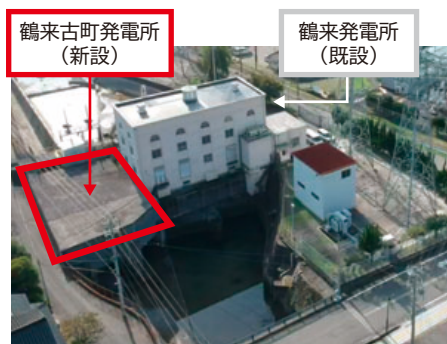
鶴来古町発電所の全景
