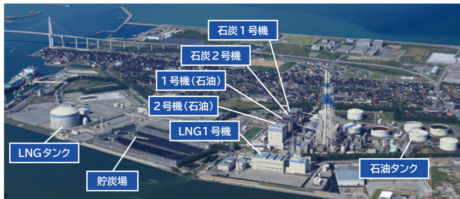
国内でも珍しい3種類の燃料(石油、石炭、LNG)を扱う富山新港火力発電所
