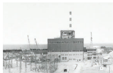
富山火力発電所1号機
