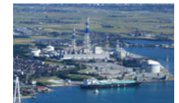
富山新港火力発電所LNG1号機
