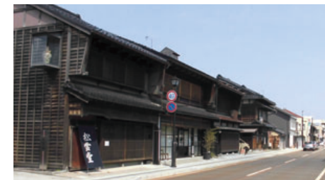
無電柱化した小松市龍助町の街並み
