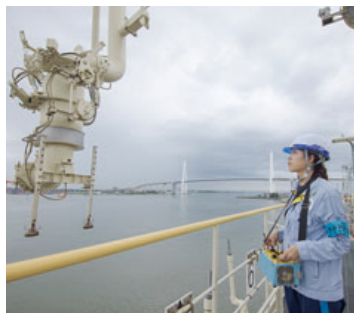
LNGアンローディングアーム事前点検
