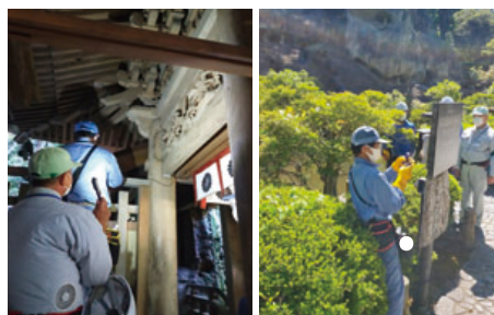
国指定重要文化財「那谷寺」の電気設備点検
