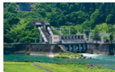
神通川第一発電所(水力)
