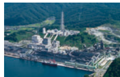
敦賀火力発電所1号機
