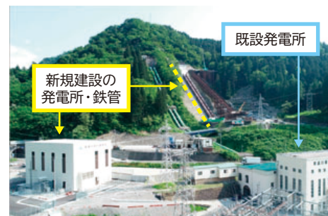
新姫川第六発電所
