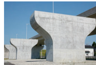
高岡環状線高架橋脚
