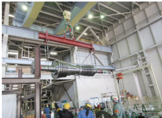
七尾大田1号機タービン取替作業の様子
