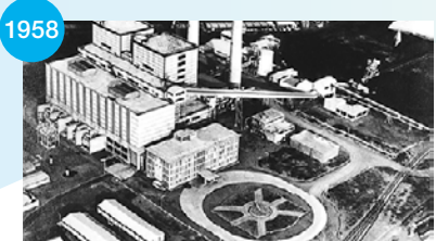
当社初の大型火力 八戸火力発電所1号機が運転開始
