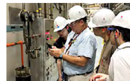
ハッチ原子力発電所への運転員の派遣（現場パトロールに同行している様子）
