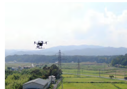
ドローンによる送電線の巡視状況
