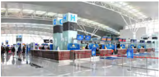
ノイバイ国際空港第2ターミナル（ベトナム）
