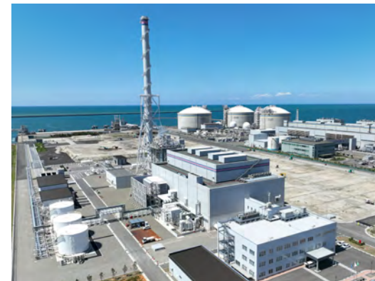
上越火力発電所全景
