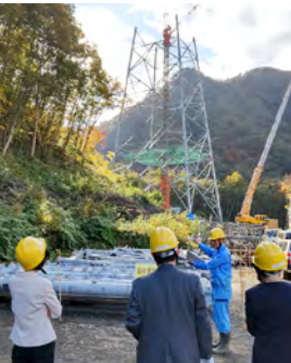
社外取締役による現場視察の様子
