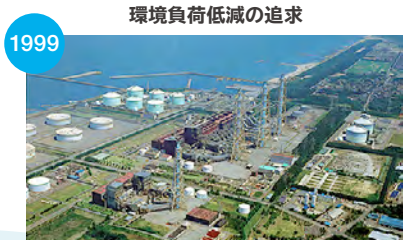
東新潟火力発電所4-1号系列運転開始 (当時世界最高クラスの熱効率55%以上を達成)
