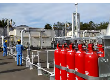
新潟火力5号系列での水素混焼試験の様子
