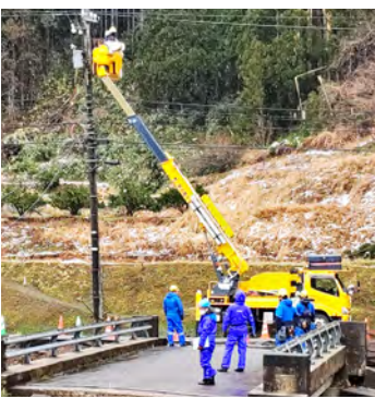
令和6年能登半島地震で被害を受けた石川県における応援復旧作業の様子
