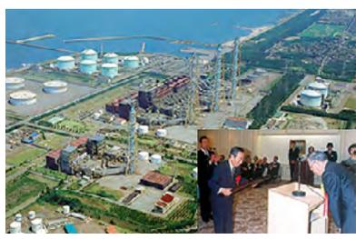
東新瀧火力発電所4-1号系列は当時世界最高クラスの熱効率55%以上を達成
