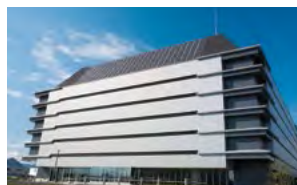
新高松データセンター 「Powerico(パワリコ)」
