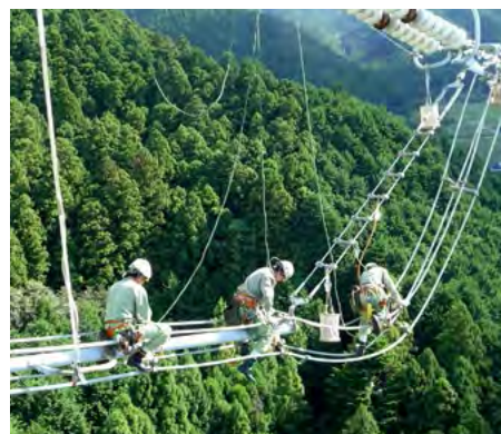
多回線化した送電線の点検
