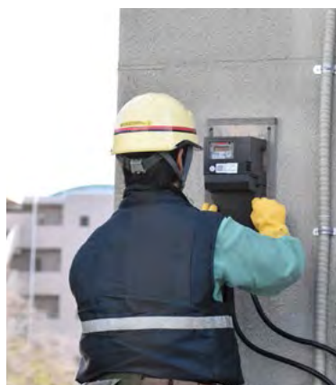
スマートメーターへの取替
