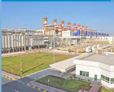
カタール国 ラスラファンC発電・造水プロジェクト プラント全景
