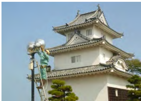
丸亀城を照らすライトの点検（高松支店）
