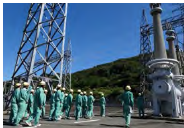
讃岐変電所での設備見学の様子
