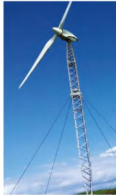
▲可倒式風力発電設備
