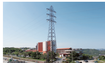
環境調和色送電線鉄塔（南城市） 「南城市景観まちづくり条例」に基づき、公共施設など一帯の景観および周辺環境に配慮した環境調和色送電鉄塔（ダークブラウン）を採用しました。
