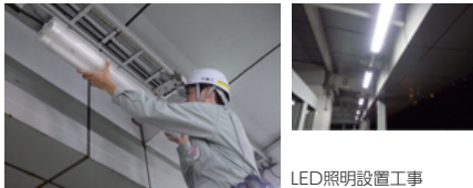
LED照明設置工事
