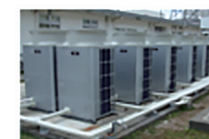
省エネ設備改修工事
