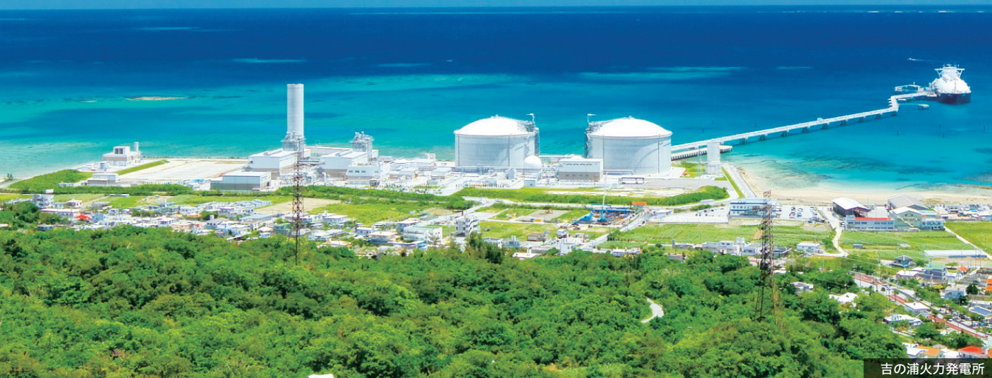
吉の浦火力発電所
