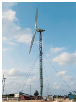
▲多良間可倒式風力発電設備・傾倒時
