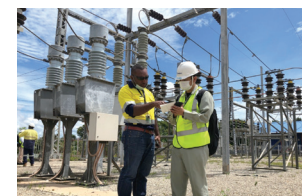
変電所における現場確認
