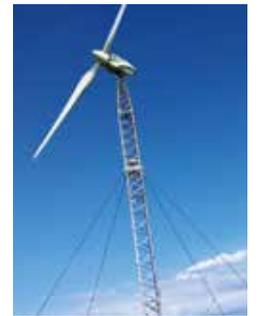
▲可倒式風力発電設備
