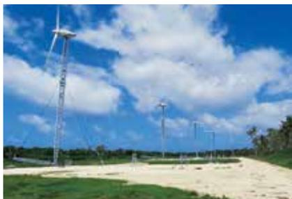
▲トンガ王国へ納入した可倒式風力発電設備
