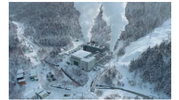
鬼首地熱発電所
