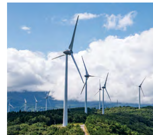
にかほ第二風力発電所
