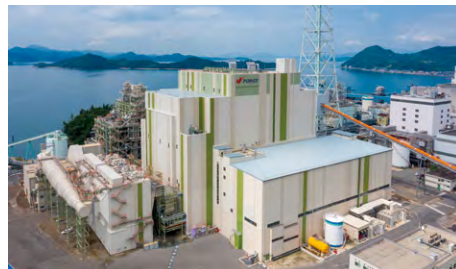
竹原火力発電所新1号機
