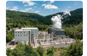
宮城県 鬼首地熱発電所 持分出力：14.9MW
