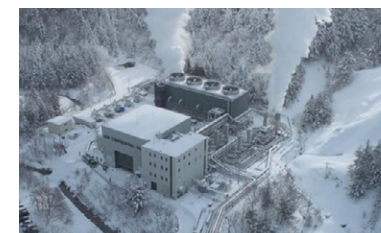
鬼首地熱発電所
