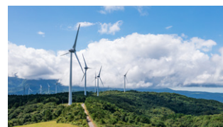
にかほ第二風力発電所
