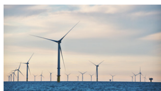
トライトン・ノール洋上風力発電所(英国)
