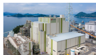
竹原火力発電所新1号機
