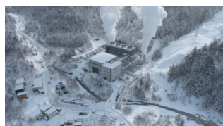
鬼首地熱発電所
