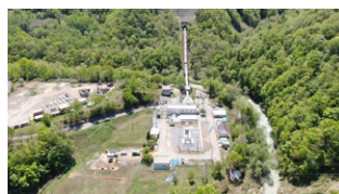
新桂沢発電所
