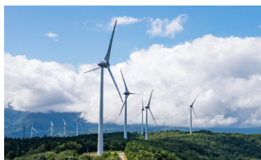
にかほ第二風力発電所
