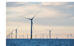
トライトン・ノール洋上風力発電所(英国)
