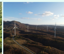
北海道 江差風力発電所 持分出力 14.7MW
