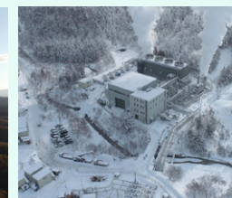
宮城県 鬼首地熱発電所 持分出力 14.9MW
