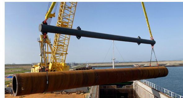
風車の基礎となる杭の搬入
