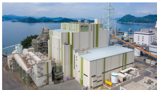
竹原火力発電所新1号機
