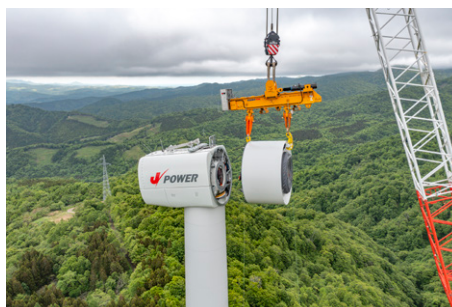
上ノ国第二風力発電所の建設
