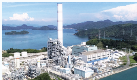
大崎クールジェン 酸素吹IGCC+CO 2 分離・回収プロセス実証設備
