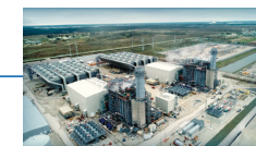
米国 ジャクソンガス火力発電所
