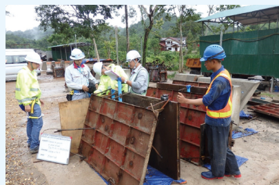
コンクリート用型枠検査立会の様子
