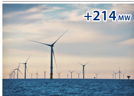
英国 トライトン・ノール洋上風力発電所
