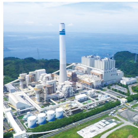
現在の松島火力発電所
