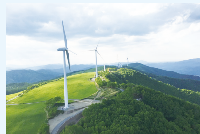
くずまき第二風力発電所の建設工事
