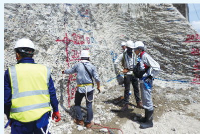
施工状況検査の様子
