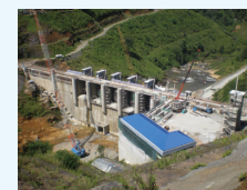
アップーコトマレダム建設の様子
