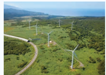
島牧ウインドファーム (2021年5月リプレース工事着工)
