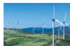
⑥ くずまき第二風力発電所運転開始
