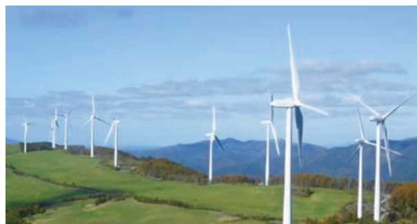
くずまき第二風力発電所（2020年12月営業運転開始）
