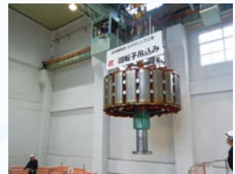
足寄発電所2号機一括更新工事 (2021年2月19日運転開始)
