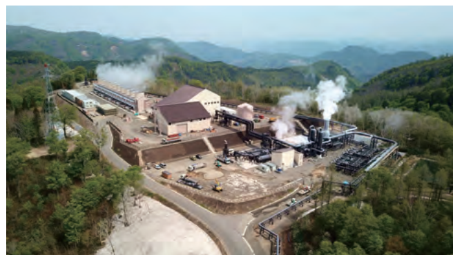
山葵沢地熱発電所(秋田県)
