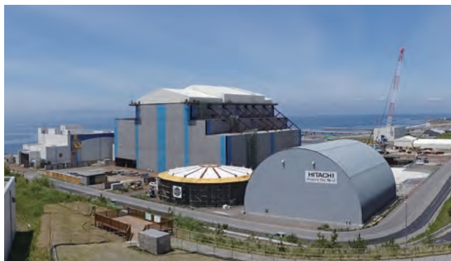
大間原子力発電所の建設状況(2019年6月時点)
