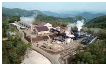
山葵沢地熱発電所(秋田県)
