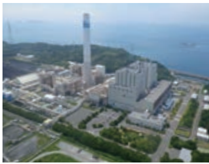
松島火力発電所(現在) 長崎県西海市
