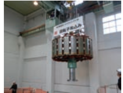
回転子吊込みの様子(2020年11月)
