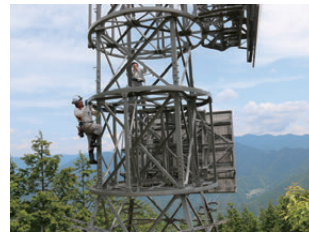
通信鉄塔巡視点検
