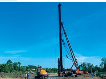
基礎工事（試験杭打ち）
