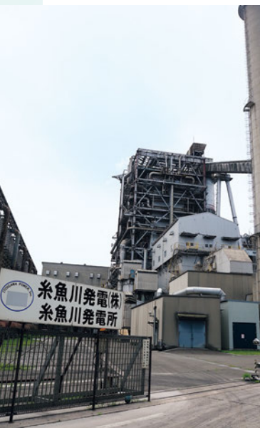
糸魚川発電所
