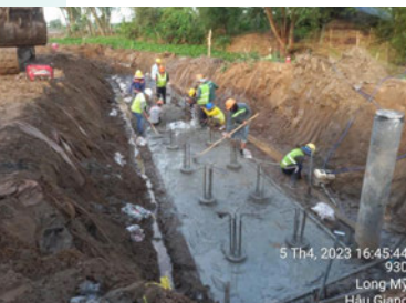
敷地境界の堰堤工事
