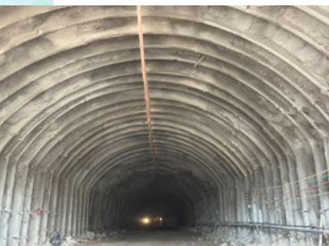
迂回トンネル上流口から見たトンネル内部
