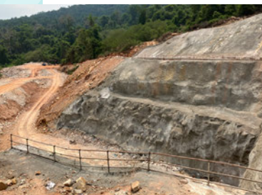
迂回トンネル上流口
