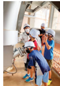
ボイラ内部を覗く様子
