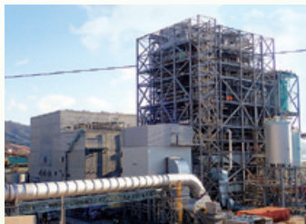
大船渡バイオマス発電所
