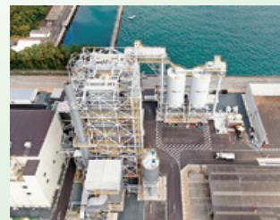
豊前バイオマス発電所
