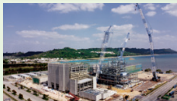
沖縄県うるま市 中城バイオマス発電所(建設中)
