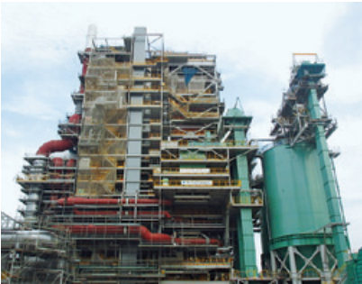
*写真：建設中の佐伯発電所
