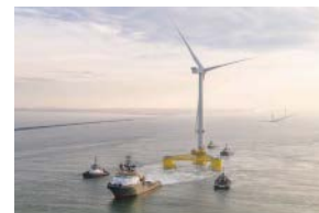
洋上風力発電 画像提供：プリンシプル・パワー
