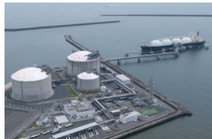
日立LNG基地
