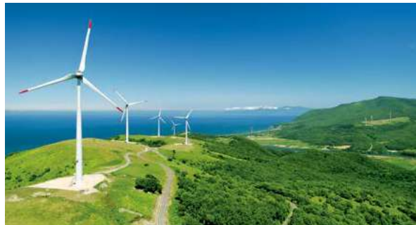
尻別風力発電所(北海道)
