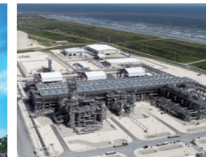
米国フリーポートLNG基地 Freeport LNG Development, L.P.提供
