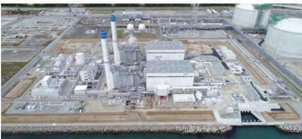
福島天然ガス発電所
