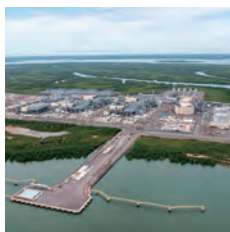
豪州イクシスLNGプロジェクト 国際石油開発帝石(株)提供
