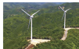
印南風力発電所
