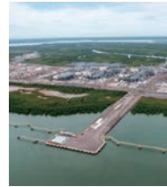
イクシス LNGプロジェクト
