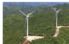
印南風力発電所
