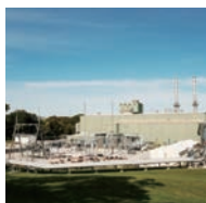
ミシガンパワー 天然ガス火力発電所
