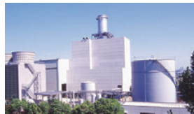
西島エネルギーセンター
