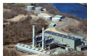
クリーンエナジー天然ガス火力発電所
