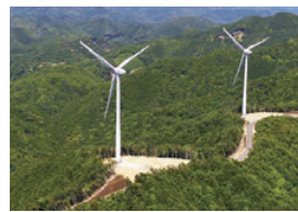
印南風力発電所
