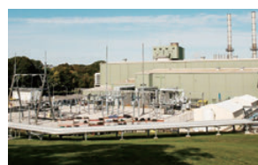
ミシガンパワー天然ガス火力発電所
