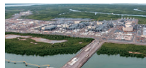
イクシスLNGプロジェクト
