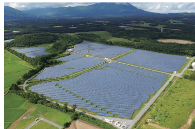
雫石太陽光発電所（岩手県）
