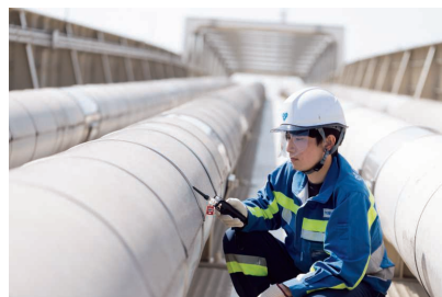
橋梁管の安全点検の様子
