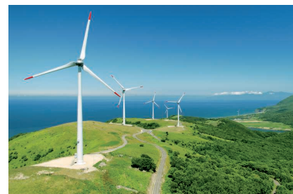
尻別風力発電所(北海道)
