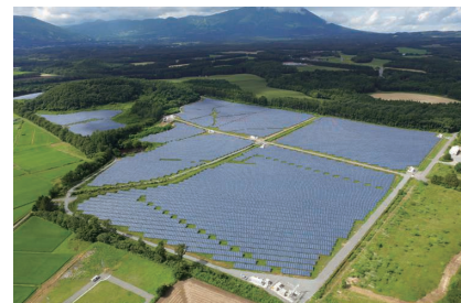
雫石太陽光発電所(岩手県)
