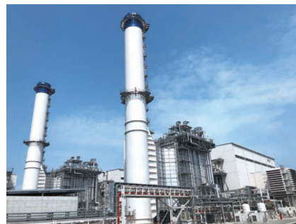
福島天然ガス火力発電所(福島県)
